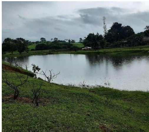
Reservatório de Água
