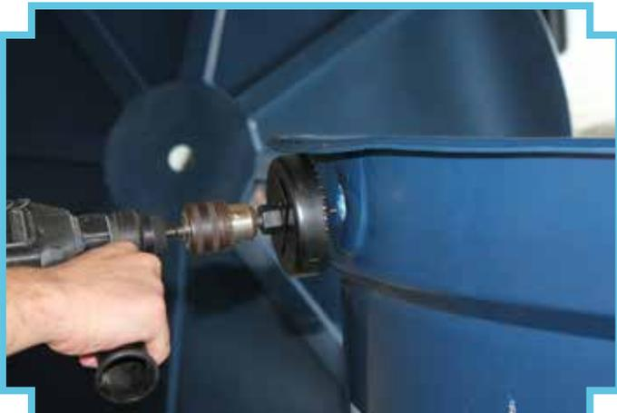
1 - Faça um furo na parte superior no lado esquerdo da caixa. Use uma furadeira com serra-copo de 100 mm
