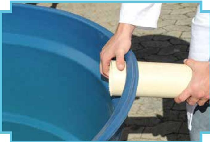
1- Coloque o cano de 100 mm de PVC no furo da caixa d'água
