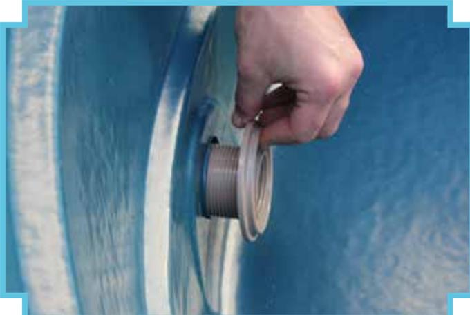
5 - Encaixe a rosca maior no flange por dentro do furo da caixa d'água
