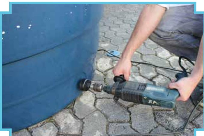
3 - Faça um furo na parte inferior no lado direito da caixa d'água com a ponta serra-copo de 50 mm
