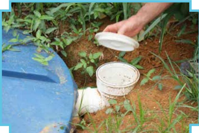
3 - Abra a tampa da válvula de retenção
