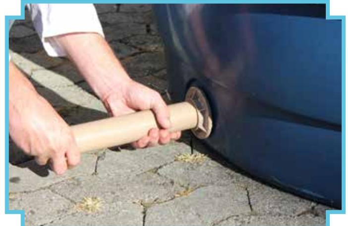
9 - Encaixe o cano de 30 cm de PVC e 50 mm na saída da terceira caixa d'água
