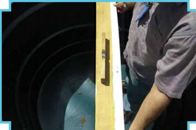
3 - Coloque a caixa d'água no buraco e com um nível de pedreiro, nivele o fundo em todas as direções
