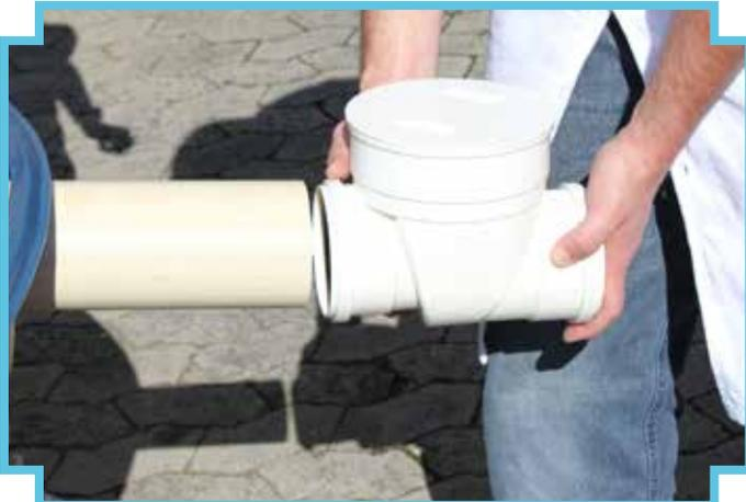
3 - Encaixe a válvula de retenção no final do cano de 100 mm
