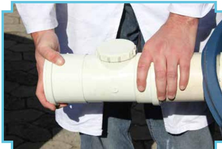
8 - Encaixe o tê de inspeção no final da curva da primeira caixa d'água
