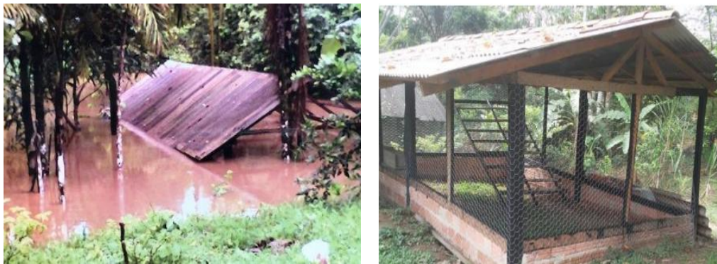
Figuras 57 e 58. Evolução de Infraestrutura “Galinheiro” após o recebimento do Fomento Fonte: EMATER-RO, Esloc Porto Velho, 2019
